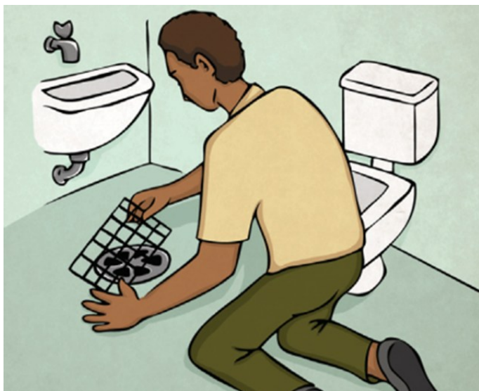
Figura 10. Limpar periodicamente ralos de banheiro, cozinha e caixas de gordura.
